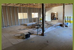
TRAVAUX RÉALISÉS À WISCHES
